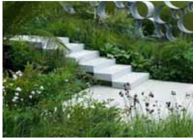
Blockstufen mit seitlicher Ablösung vom Terrain
